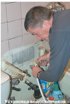
Установка водосчетчиков
